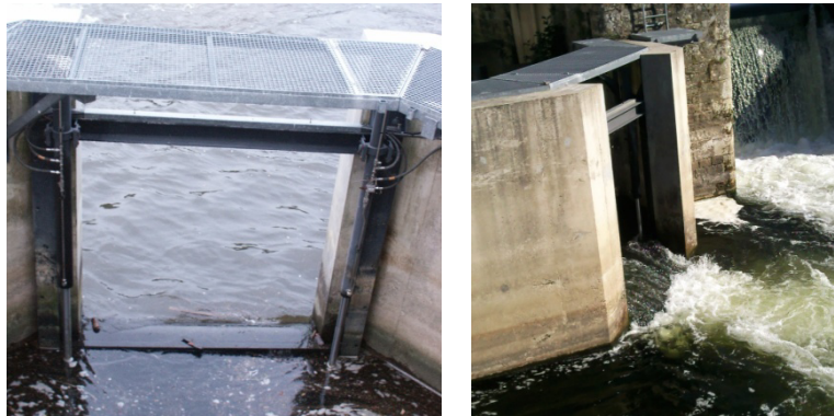
Figure 27 : Vanne de régulation de la chute au niveau de l'entrée piscicole d'une passe à bassins
