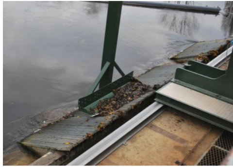
Figure 60 : Dégrillage en cours de réalisation
