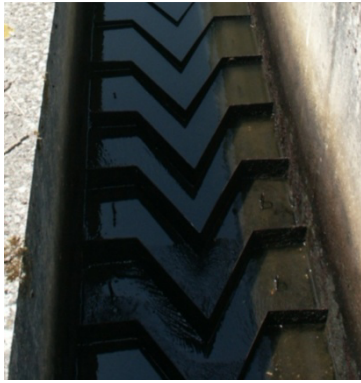
Figure 31 : Ralentisseurs de fond suractifs
