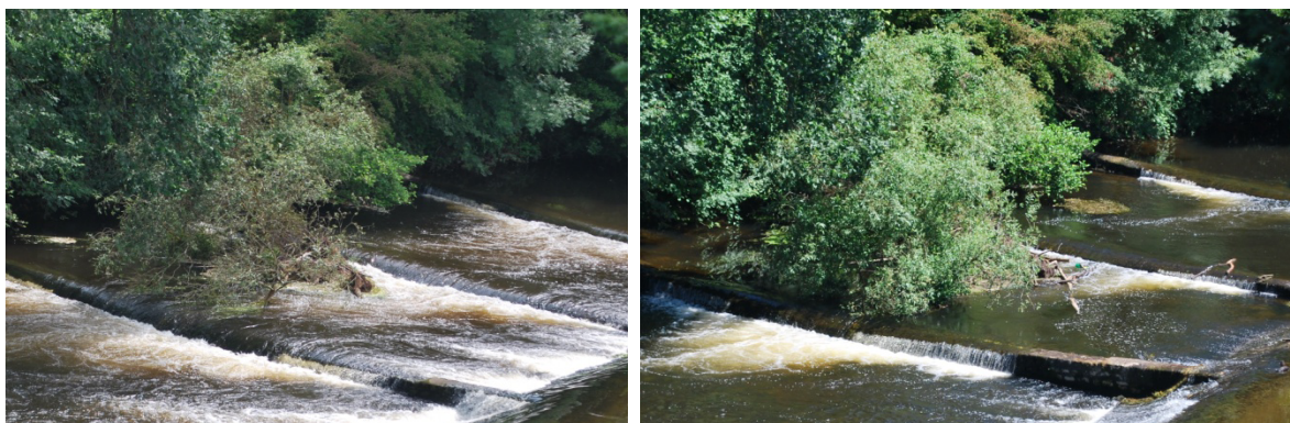
Figure 48 : Encombrement d'un prébarrage
