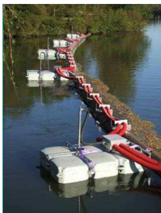
Figure 6 : test par télémétrie de l'efficacité de deux barrières à infrasons aux centrales de Baigts et Biron sur le gave de Pau. Source : Profish (Larinier, Thévenet, & Travade, 2008)
