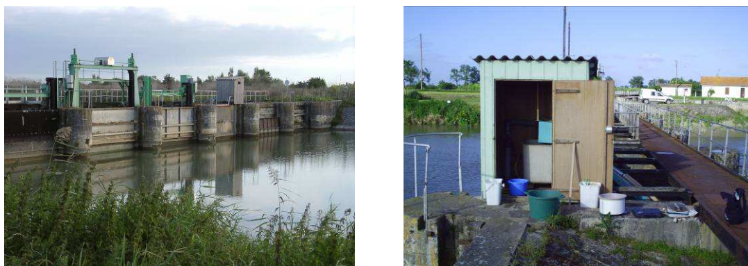
Fig 17 : photos de la passe à anguille du barrage des Enfreneaux
