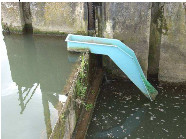
Fig.3 : passe à anguille de la Sotterie sur la Sèvre niortaise (alimentation gravitaire)
