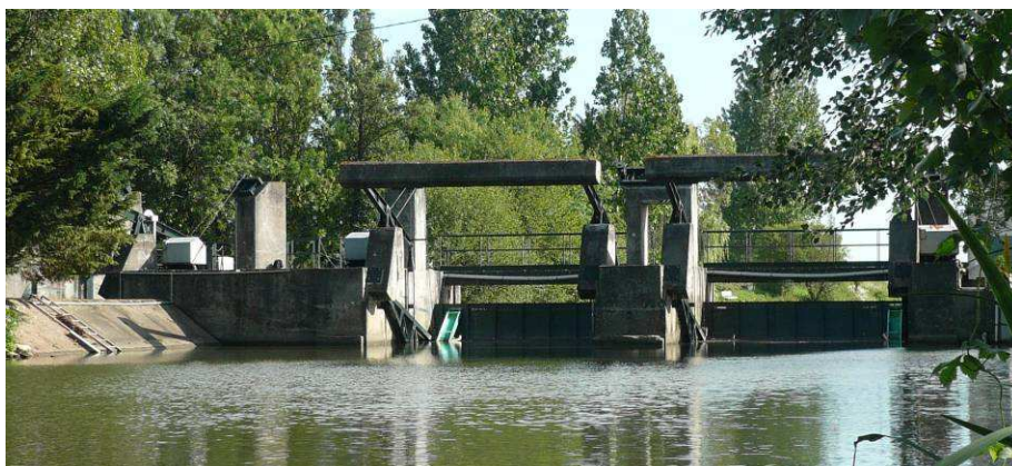
Fig. 29 : barrage de la Boule d'Or (Vendée) et ses passes à anguille en rives droite et gauche
