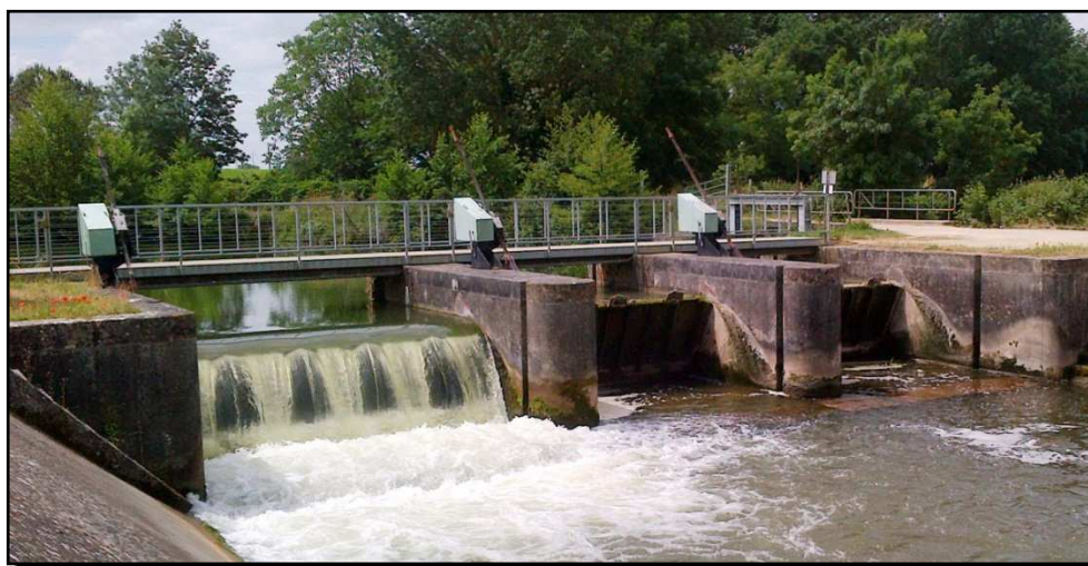
Figure 10. Photographie du barrage de Marais pin à Magné (Source AS. Bazile)
