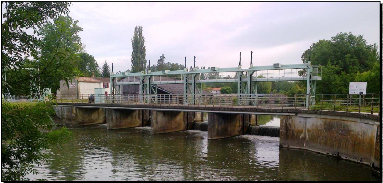
Figure 9. Photographie du barrage de la Sotterie à Coulon (Source AS. Bazile)
