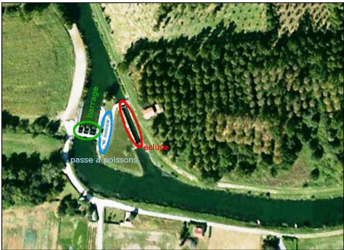
Figure 11. Photographie aérienne du barrage de Marais pin (Source Google Earth)
