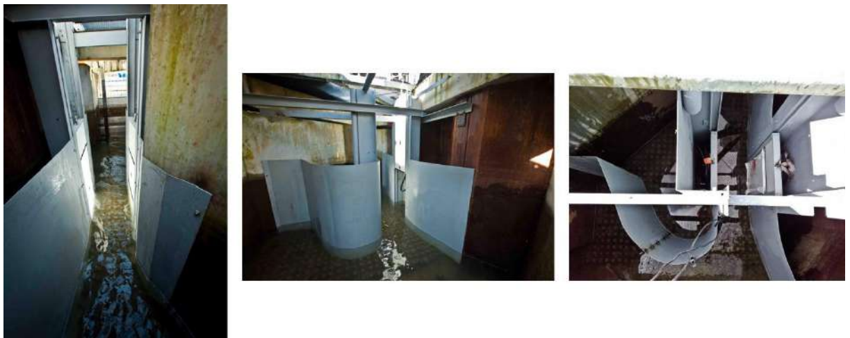
Figure 6 : Projections 3D et photographies de la structure d'accueil métallique sur-mesure conçue pour intégrer le dispositif de vidéo-comptage dans la passe à poissons de la Sotterie
