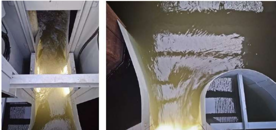
Figure 7 : Conditions hydrauliques au droit du dispositif de vidéo-comptage générées par les entonnements amont
