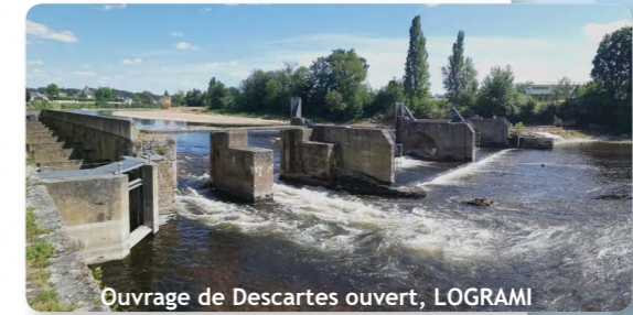
barrage et ses conséquences (continuité, habitats, usages, ouvrages d'art, etc.).
