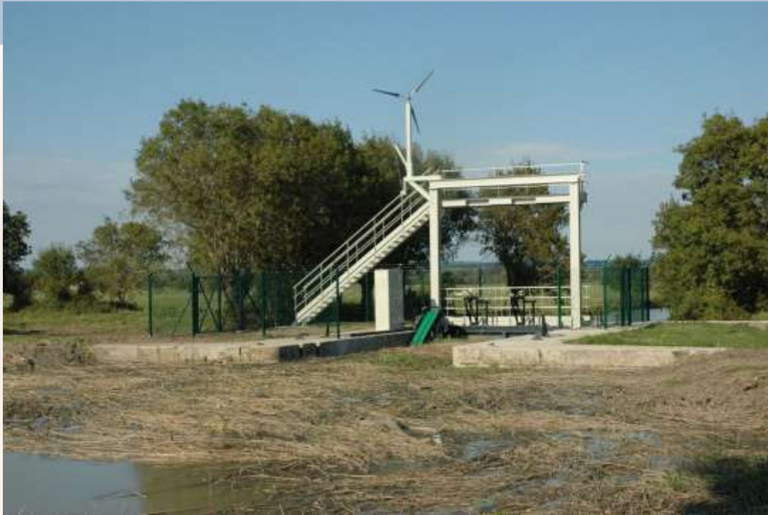
Passé à civelles (2007) pour écluse de Vair (27 000 €)
