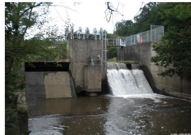
Barrage de Pontécoulant sur la Druance
