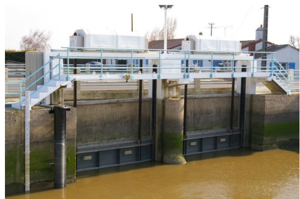
Ouvrage à la mer du port de La Barre-de-Monts en Vendée (Photo T. Besse LOGRAMI)
