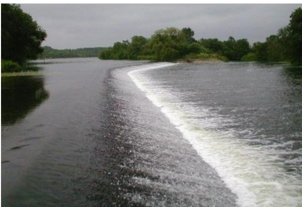
Seuil fixe à Châteauneuf (Photo P. Steinbach ONEMA)
