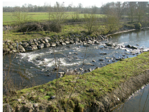
Rampe en enrochement sur l'Yon
