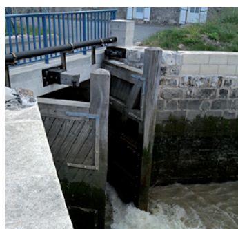
Illustration des typologies d'ouvrages en marais (vanne + porte à flot, vanne simple, clapet à la mer)
