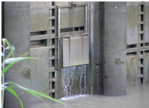
Vantelles sur l'ouvrage de Buzay
