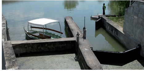
Illustration des typologies d'ouvrages en marais (clapet, écluse, batardeau)
