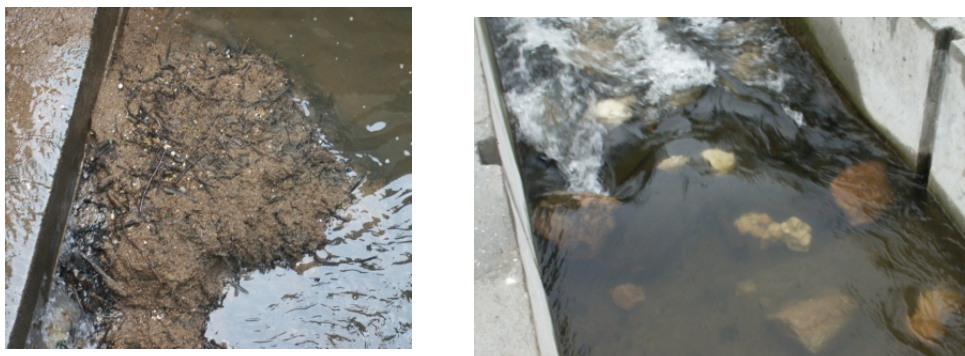
Figure 8 : Engrèvement d'une passe à bassins (à gauche) et d'une passe à ralentisseurs (à droite)
