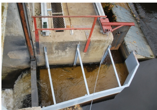
Figure 58 : Dispositif de dévalaison et plan de grille associé
