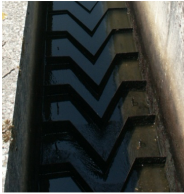
Figure 31 : Ralentisseurs de fond suractifs
