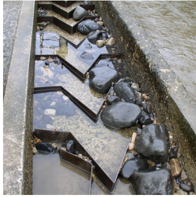
Figure 37 : Passe à ralentisseurs de fond engravée
