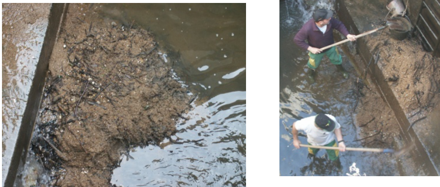
Figure 22 : Engrèvement d'un bassin (à gauche) et enlèvement des sédiments (à droite)
