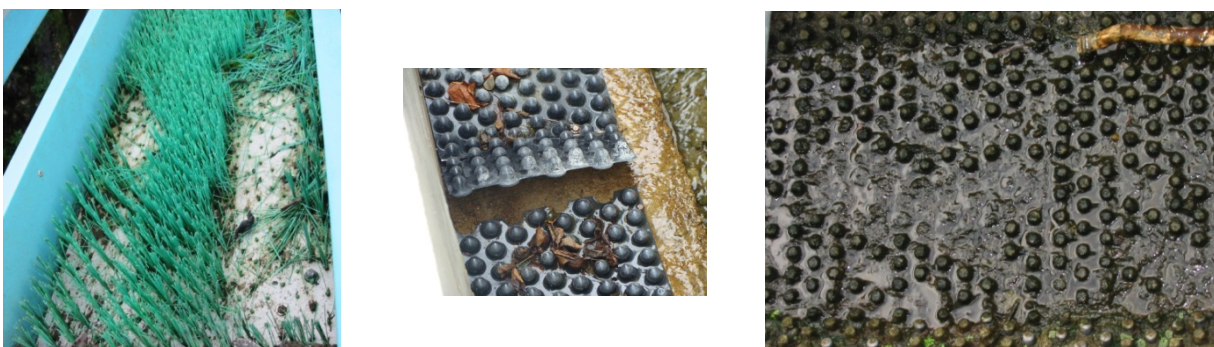
Figure 43 : Substrats de type « brosse » (à gauche), thermomoulé (au centre), ou en béton (à droite) dégradés (Source : Larinier M. et Chanseau M., 2011, Formation ICE - Production d'Informations sur la Continuité Ecologique)
