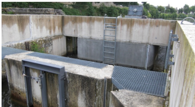
Figure 12 : Echelles d'accès et passerelles en caillebotis
