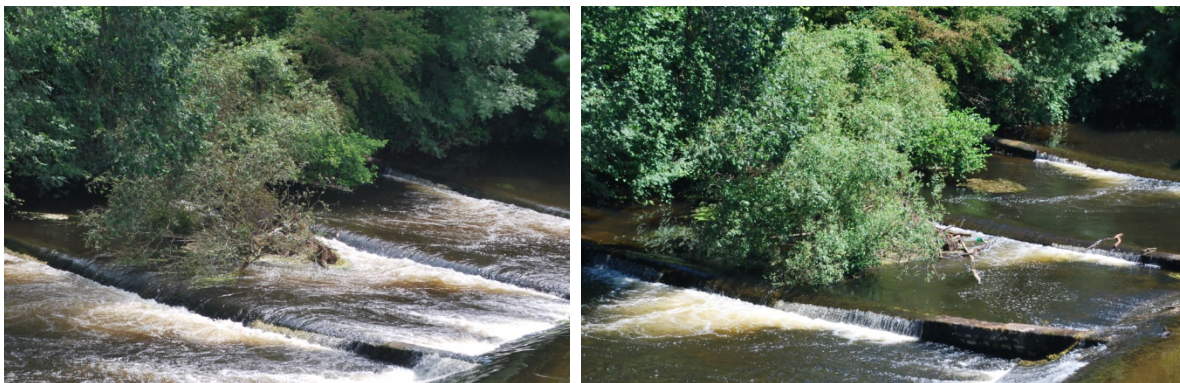
Figure 48 : Encombrement d'un prébarrage
