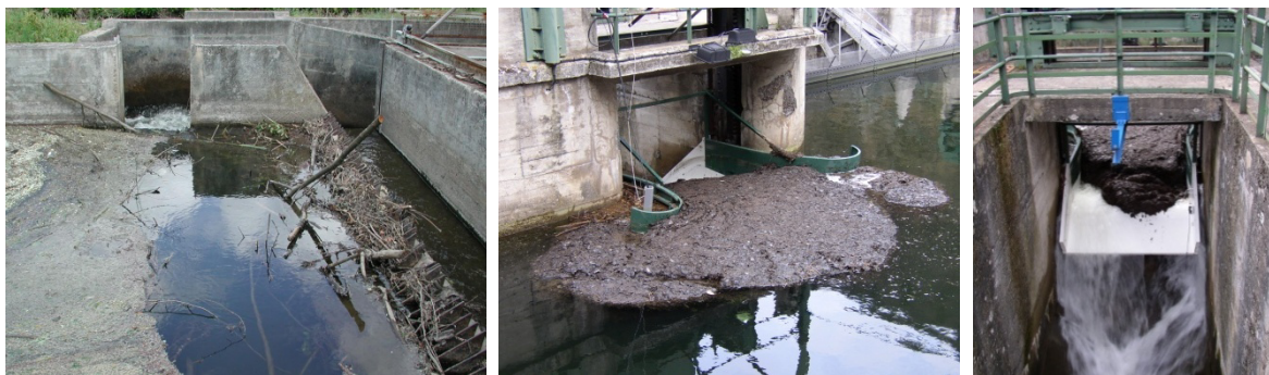
Figure 59 : Encombrement de dispositifs de dévalaison
