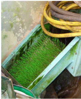
Figure 19 : Passe à civelle - Barrage des Vallées (aval)
