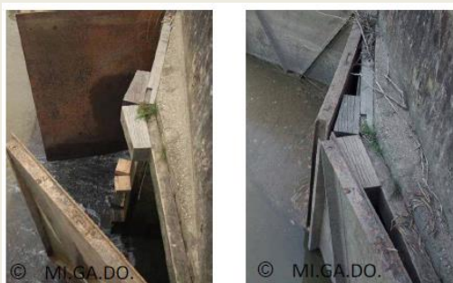
Pose de cales (à 3 niveaux) sur le cadre d'une porte à flot - Position ouverte au jusant et fermée à marée haute © Migado
