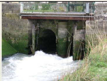
Ouvrage de Charras ( portes à flot doublées en amont de vannes à double vantelles ) - Charente © Unima
