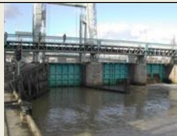
Barrage Saint Félix à Nantes ( l'une des portes levantes est la vanne aval de l'écluse de navigation ). Confluence Erdre-Loire © Val d'Erdre
