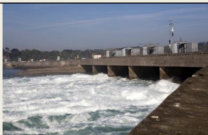
Barrage-usine marémotrice de la Rance ( admission d'eau à marée montante ) © EDF-Bruno Conty
