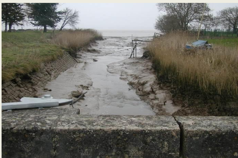
L'estey du port de Lamena (Gironde, rive gauche) à basse mer et en cours de flot. En arrière-plan, l'estuaire de la Gironde (© Pôle Eco-hydraulique)
