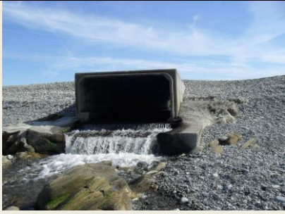
Buse pont-cadre à l'exutoire de la Virgule (Bretagne Sud-Cornouaille) © Guichard S. /Ouesco 2012
