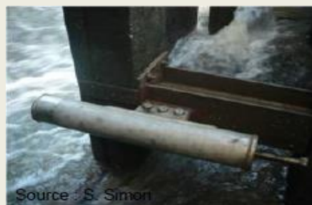
Raidisseur de clapet mis en place sur un ouvrage médocain depuis 4 ans © S. Simon (concepteur)
