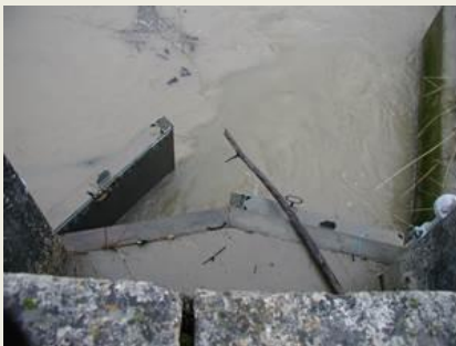
Début d'écoulement de l'eau douce au niveau des portes à flot du Port de Lamena (estuaire de la Gironde) © Pôle Ecohydraulique 2011
