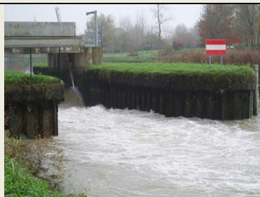
Clapet mobile + seuil fixe Saint-Savinien sur la Charente © Irstea
