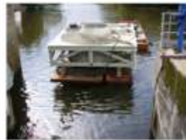
La barge entre dans l'emplacement
